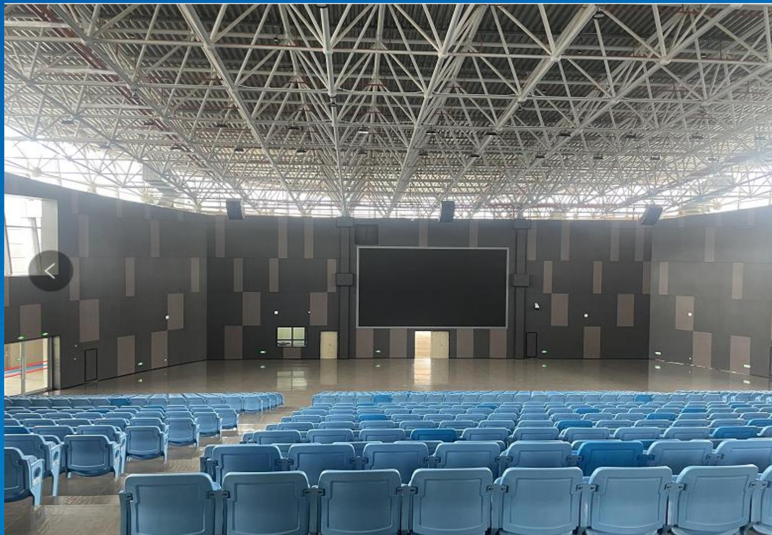
建筑面积 4636.06 m<sup>2</sup>，建筑高度 21m，地上 1 层、局部夹层 2 层，钢框架结构（减震），可容纳 1700 人（座），可用于电子竞技比赛使用，兼顾会议、演出、比赛等功能。
